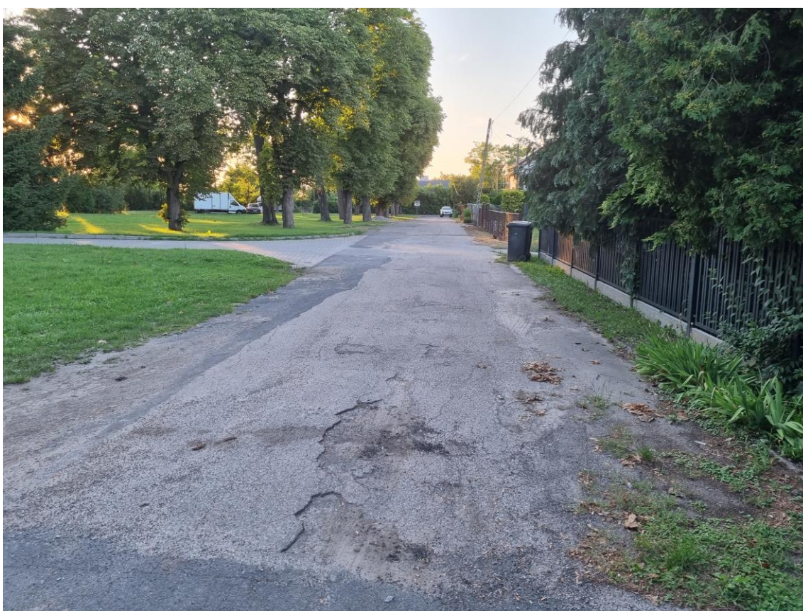
Odcinek końcowy, po lewej dojazd o naw bitum. do przychodni
