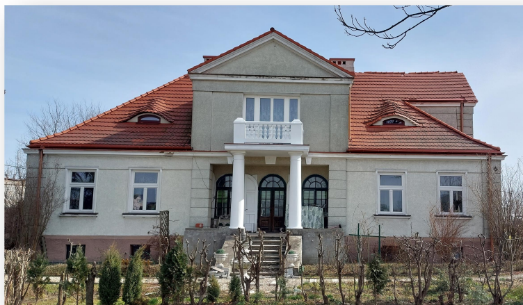
Fot. 1 Dom Rejenta - Iłów
